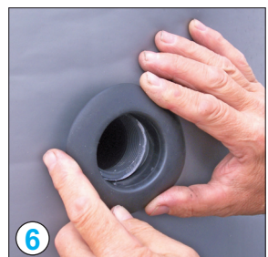
Alle Rosetten aufsetzen und eindrücken
