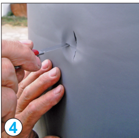
Muffen die noch unter dem PVC-Mantel liegen ertasten
