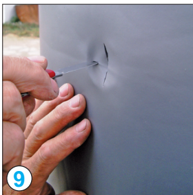
9 Muffen die noch unter dem PVC-Mantel liegen ertasten
