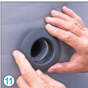
11 Alle Rosetten aufsetzen und eindrücken
