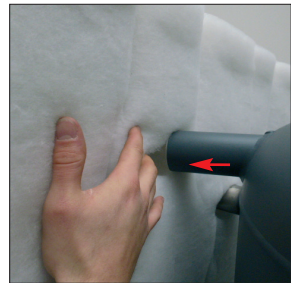
Isoliermantel dem Speicher anlegen und die Speichermuffen exakt durch die vorgestanzt Löcher führen (bei den ungenutzten Ausstattungen sollten die Schaum-Stopfen nicht entfernt werden!)
