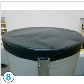
8 Oben die schwarze Speichermütze aufsetzen
