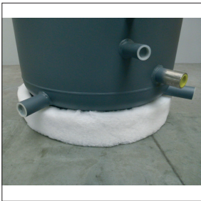
...bis zum Standring überziehen
