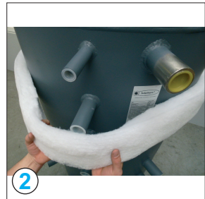
äußere Standringisolierung von oben nach unten...
