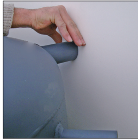
Isolierung ausschließlich in warmen Zustand anbringen. 24 Stunden auf mindestens 22 °C vorwärmen.
