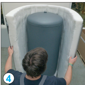
Den Speicher mit dem Isoliermantel fest umschließen
