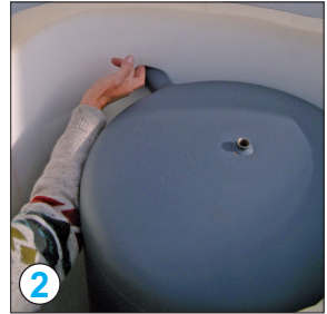
Stutzen an die Isolierung anpassen
