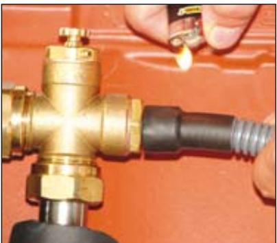
Schutzschlauch zum Aufschumpfen (Heißluft ...)
