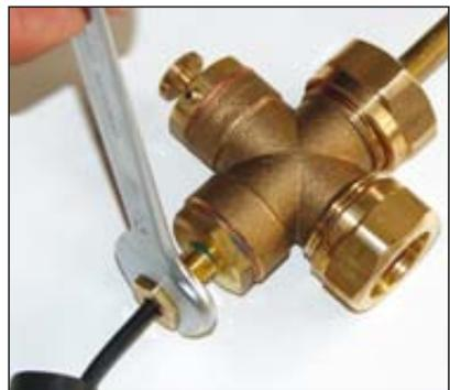
Fühler komplett in den Vorlaufanschluss stecken und Überwurfmutter festziehen
