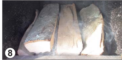
8 Untere Türe vollständig schließen und die obere Vergaserkammer mit Brennholz beladen.
