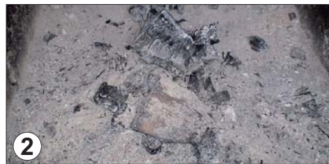
Optimaler Anheizbrennstoff sind die Holzkohlereste im Kessel. Wie im Bild gezeigt, diese über die Düse legen.
