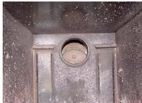
Vergaserkammer nach einigen Tagen Heizbetrieb. Die Teerbildung ist völlig normal und wird immer wieder mit abgebrannt.
