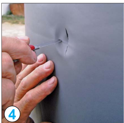
4 Muffen die noch unter dem PVC-Mantel liegen ertasten
