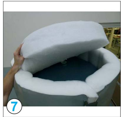
7 Deckelisolierung einlegen (Position der beiden Muffen beachten)
