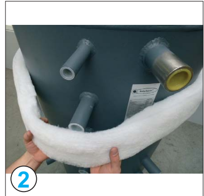
2 äußere Standringisolierung von oben nach unten...
