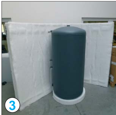
3 Isoliermantel dem Speicher anlegen und die Speichermuffen exakt durch die vorgestanzten Löcher führen (bei den ungenutzten Ausstanzungen sollten die Schaum-Stopfen nicht entfernt werden!)
