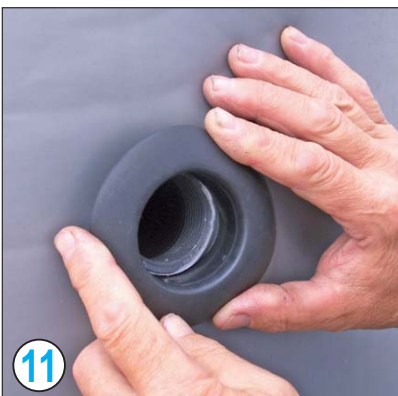
11 Alle Rosetten aufsetzen und eindrücken
