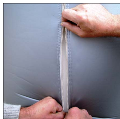
2 Stutzen an die Isolierung anpassen
