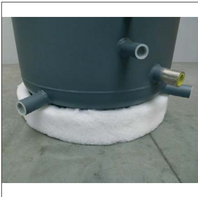
...bis zum Standring überziehen
