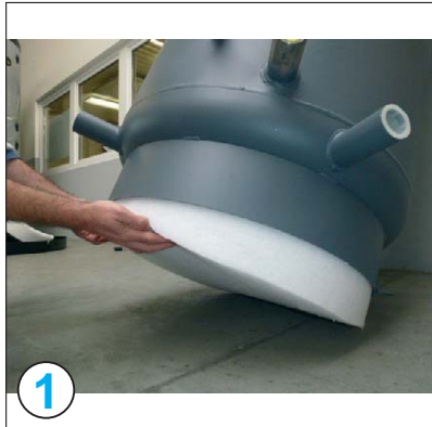
1 Pufferspeicher kippen und innere Standringisolierung einsetzen
