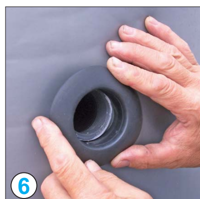
6 Alle Rosetten aufsetzen und eindrücken
