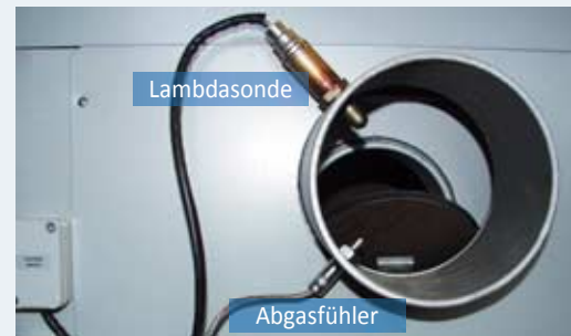
Permanente Verbrennungsoptimierung durch Abgasanalyse über die Lambdasonde und einstellbare Abgastemperatur.
