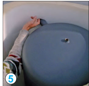
Stutzen an die Isolierung anpassen
