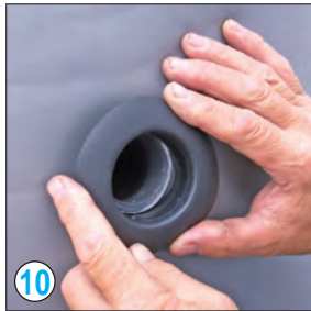
10 Manschette aufsetzen und eindrücken
