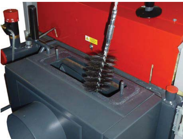
Vorführung der Reinigung des Rauchkanals mit Drahtbürste.
