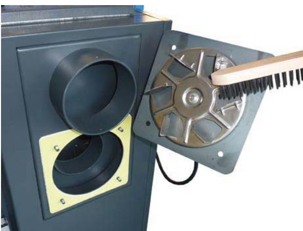
Die Reinigung des Umlaufrades und die Kontrolle des Schaufels bei Saugzugventilator
