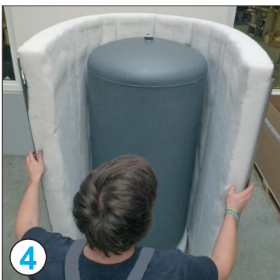
4 Den Speicher mit dem Isoliermantel fest umschließen
