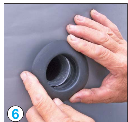
Alle Rosetten aufsetzen und eindrücken
