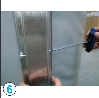
6 Alle Innensechskantschrauben ausreichend festziehen und den Isoliermantel auf Festen Sitz prüfen
