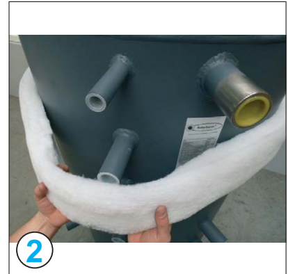
2 äußere Standringisolierung von oben nach unten...
