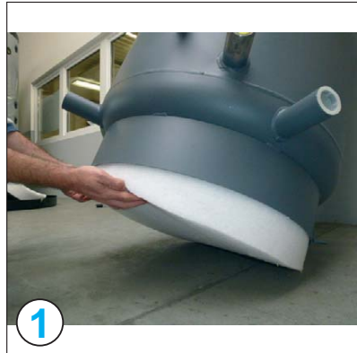
1 Pufferspeicher kippen und innere Standringisolierung einsetzen
