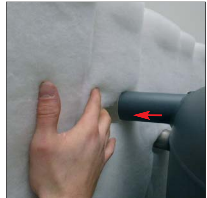
3 Isoliermantel dem Speicher anlegen und die Speichermuffen exakt durch die vorgestanzten Löcher führen (bei den ungenutzten Ausstanzungen sollten die Schaum-Stopfen nicht entfernt werden!)
