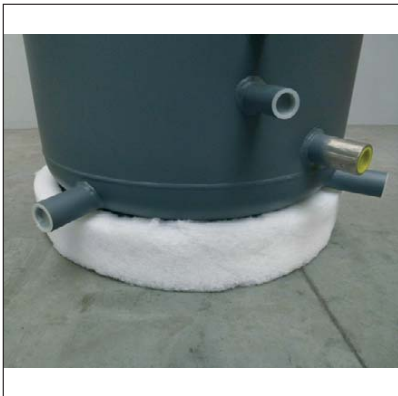
...bis zum Standring überziehen
