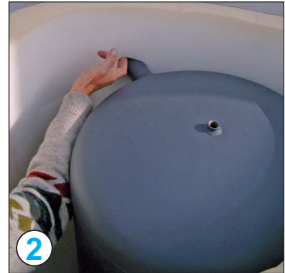
Stutzen an die Isolierung anpassen
