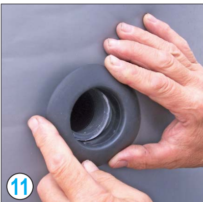
11 Alle Rosetten aufsetzen und eindrücken
